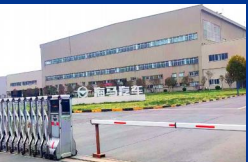
设备现场实拍
