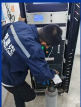
设备现场实拍
