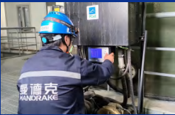
设备现场实拍
