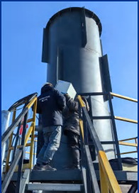
设备现场实拍
